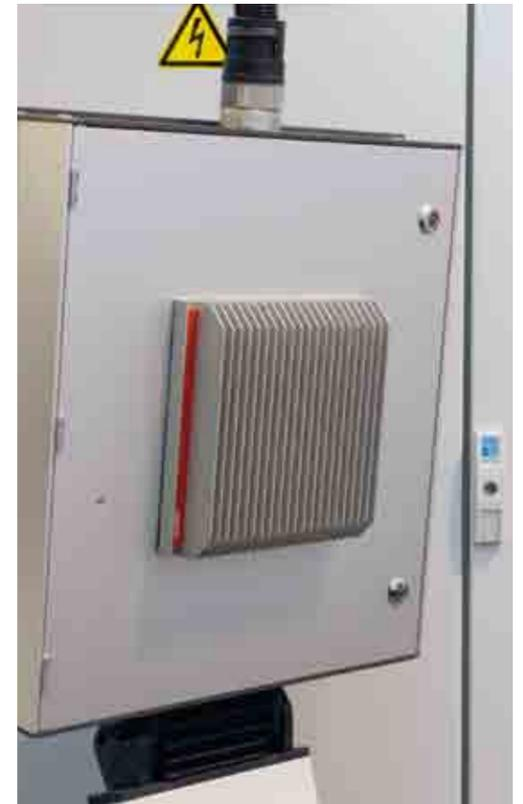
Die Steuerung wird über die Rückseite des Gehäuses gekühlt, der Lüfter entfällt.
