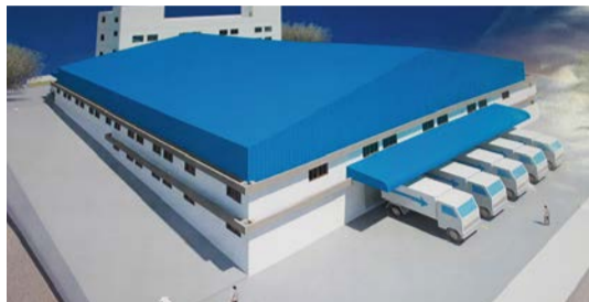
新工厂模型，2017年4月安装了两台BRUDERER冲床
